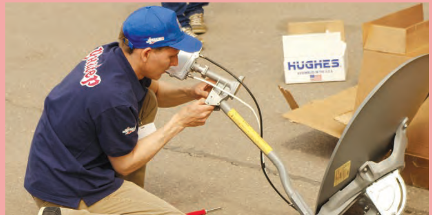
VSAT-Чемпионат 2016. Установка облучателя.
