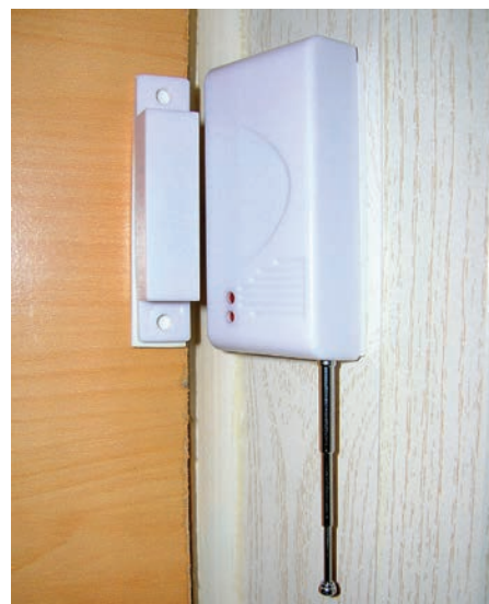
Пример монтажа датчика открывания двери
