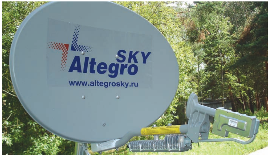
Для частных лиц в зоне покрытия спутника Astra 1F устанавливается антенна 0.74 м
